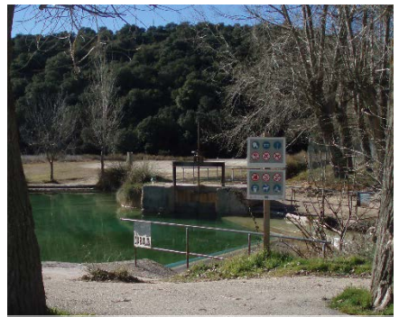
Azud que desvía los aportes de aguas superficiales hacia el baño de las mulas entre la laguna Tomilla y Tinaja
