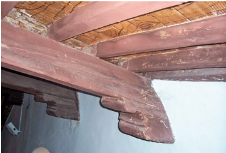
Fot. 4. Detalle de la cubierta
